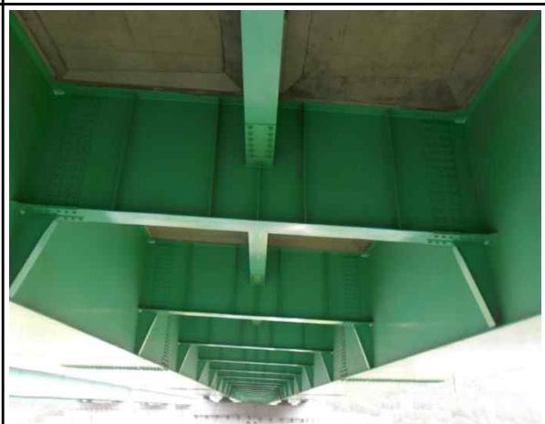
주형외부 및 바닥판 하면 전경
